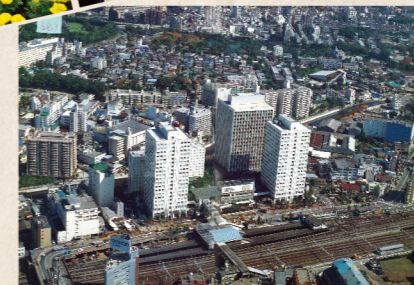
昭和62年に完成した再開発の街「大崎ニューシティ」。大崎駅前郵便局もこれに伴い現在地に移築となる
