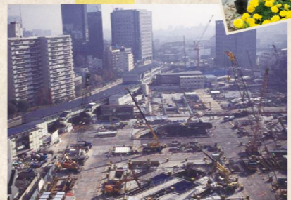
「東京都長期計画」(昭和57年)による大崎副都心の指定が端緒となり、再開発が開始された大崎駅東口地区
