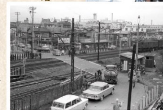
昭和45年まであった百反坂下の踏切。道は写真手前の広町1丁目、第一三共方面へ続いた
