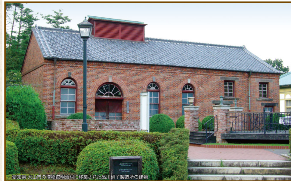
愛知県・犬山市の博物館明治村に移築された品川硝子製造所の建物
